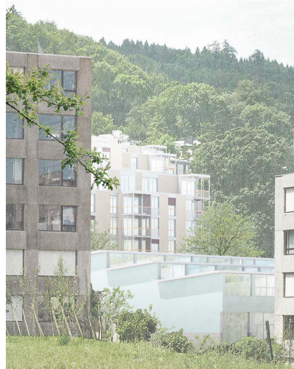
Blick auf den Flachbau aus dem Hof der 1. Etappe der Siedlung.
